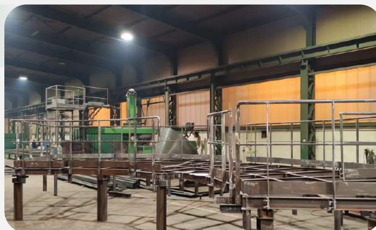
KONSTRUKCJA PODESTU NA DACH SILOSA
